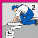
Тщательно заделайте все отверстия и трещины в полу, чтобы предотвратить утечку выравнивающей смеси и усадку затвердевшего пола. По периметру помещения установите изоляционный шов с помощью кромочной ленты.
