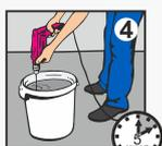
Для подготовки раствора залейте водопроводную воду комнатной температуры в чистую ёмкость из расчёта 0,29 - 0,32 л воды на 1 кг сухой смеси. Засыпая сухую смесь в воду, перемешивайте раствор дрелью со специальной насадкой на низких оборотах до получения однородной массы. Подождите 5 минут, после этого перемешайте повторно. Время пригодности раствора к работе не менее 30 минут.
