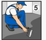
Раствор разлейте на поверхности по маякам, установленным параллельно друг другу на расстоянии на 15-20% меньшем длины правила, и распределите широким правилом. При слое меньше 10 мм установка маяков не требуется. Выравнивание поверхности производите за один прием, без перерывов.
